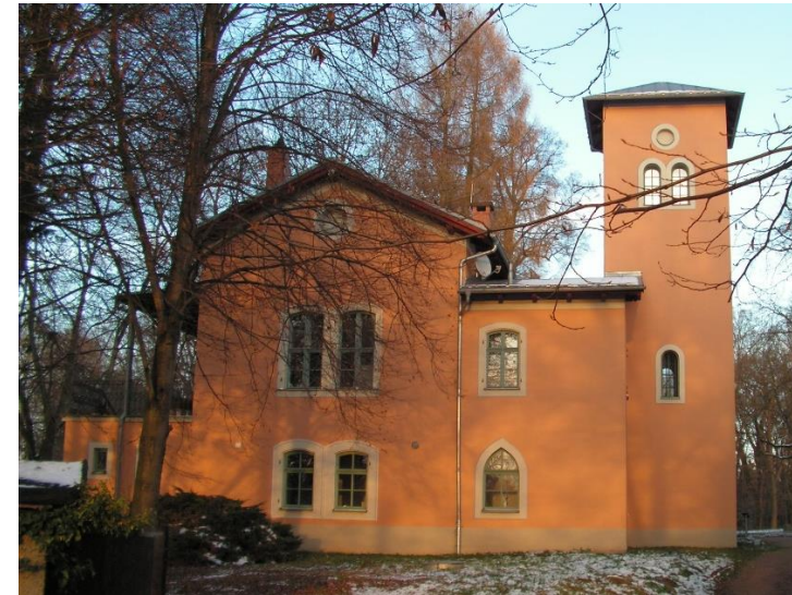
Die ehemalige Hofküche, das heutige Teehaus. Im Erdgeschoss ist noch ein gotisches Fenster der alten Hofküche erkennbar. (Foto: Alexandra Thümmeler)
