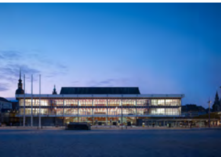
Blick vom Dresdner Altmarkt zum Kulturpalast, in dem sich das Zentrum für Baukultur Sachsen befindet.
