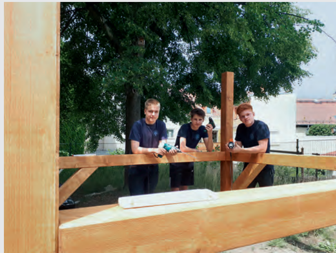
Die Überdachung für den zukünftigen Lehmbrocken entsteht
