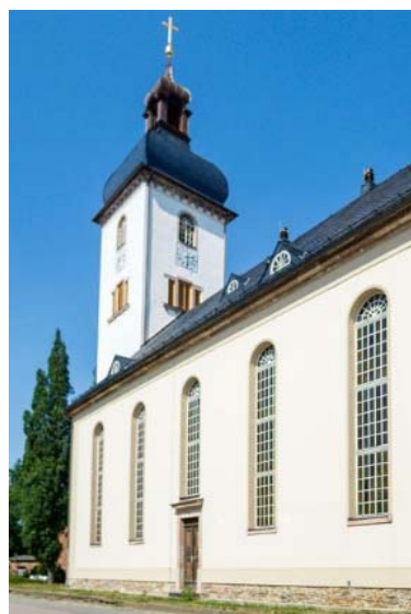
Sanierung von Kirchen (37 %)
