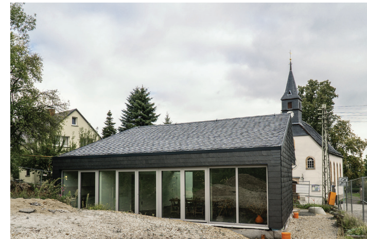
Foto Gemeindehaus: Die Außenanlagen sind noch nicht fertiggestellt. Architektur: ABOA Architekten
